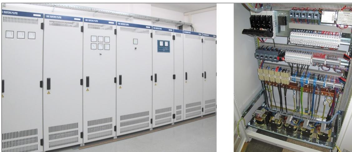
**Abb. 3-11: USV-Anlage eines ESTW**
