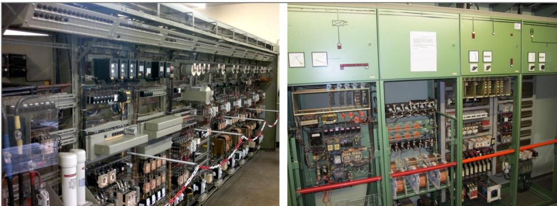
**Abb. 3-8: RSTW EV-Anlagen in Schalttafel (links) und Gestellbauweise (rechts)**
