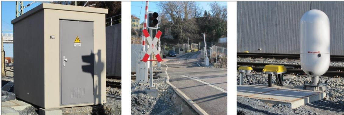
**Abb. 2-4: Schalthaus und Außenanlagen einer BÜSA**
