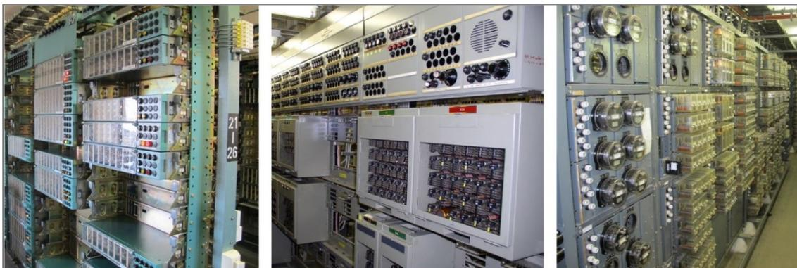
**Abb. 3-6: Relaisgestelle in Relaisstellwerken**
