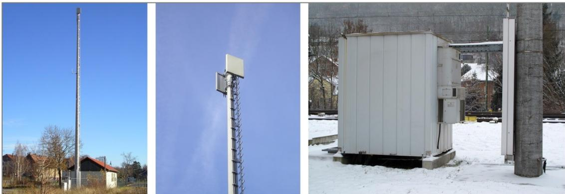
**Abb. 2-2: Sendemast und Technikcontainer GSM-R BTS**
