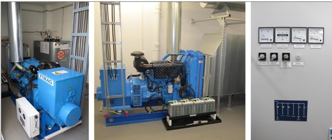
**Abb. 2-15: Diesel-NEA und NEA-Schaltschrank**
