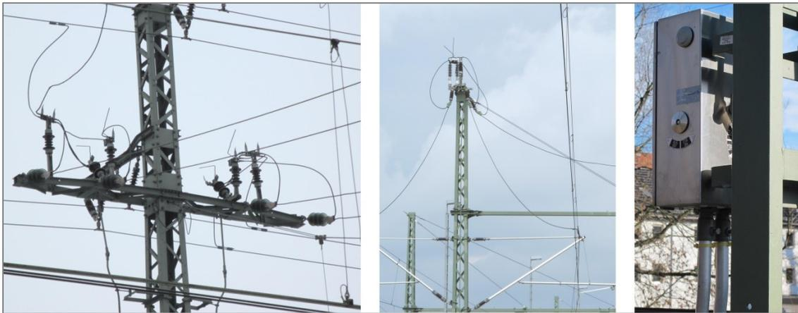
**Abb. 2-1: Mastschalter und Schalterantrieb der OSE**
