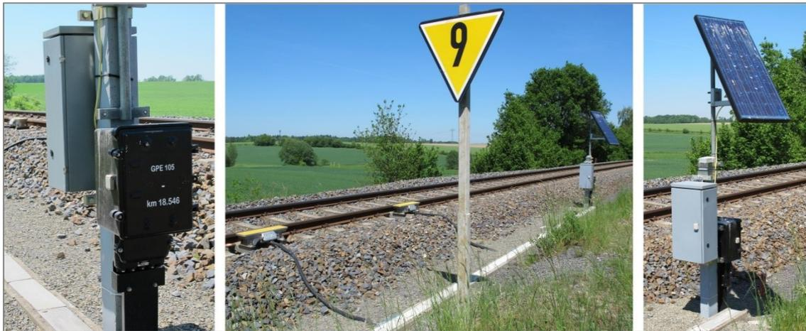
**Abb. 2-10: Anwendung der Photovoltaik bei Geschwindigkeitsprüfeinrichtungen**
