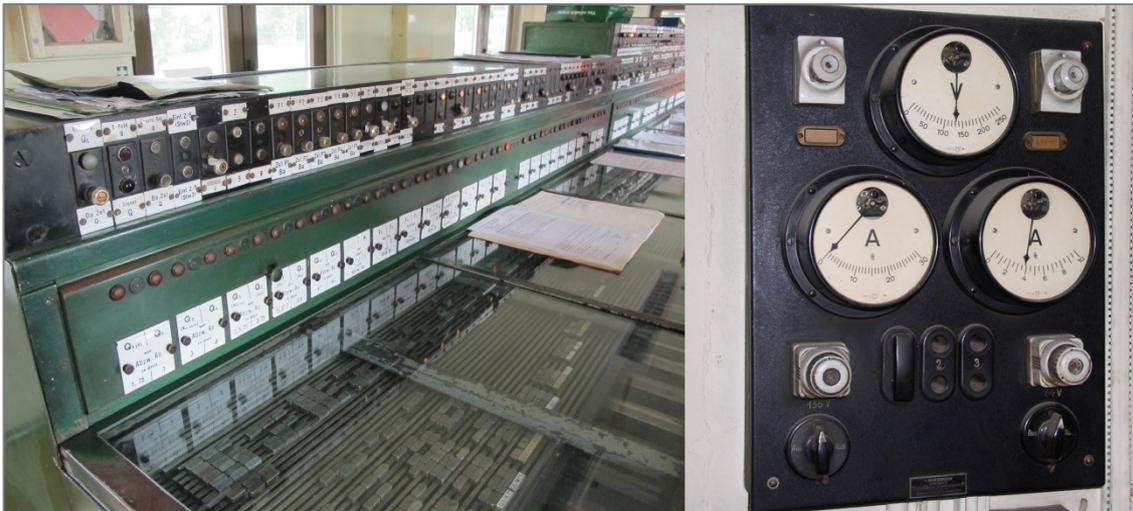
**Abb. 3-3: Emech. Stw und kleine Schalttafel im Bedienraum (Foto rechts: U. Maschek)**
