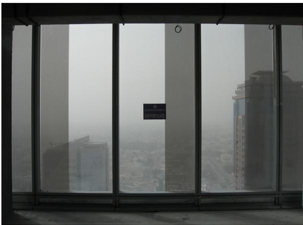
**Bild 2** Partieller Siebdruck als Sonnenschutz und Gestaltungselement
