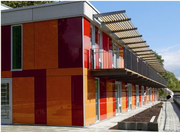
**Bild 1** Vollflächig emailliertes Glas als gestaltbildender Bestandteil einer vorgehängten, hinterlüfteten Fassade
