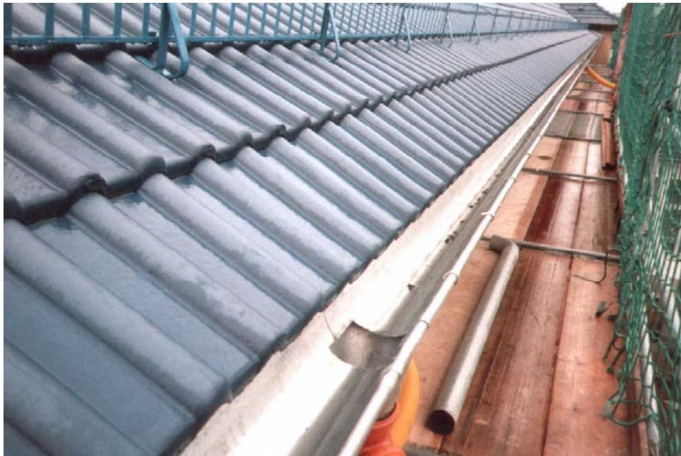
*Abbildung 17: Dachrinne und Einlauföffnung zum Fallrohr
