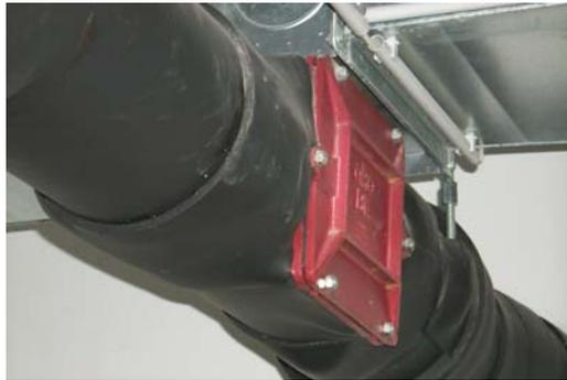
Abbildung 6: Reinigungsöffnung FEP Technikum
