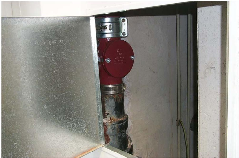
*Abbildung 18: Reinigungsöffnung einer Regenwasserfalleitung im IKTS Altbau
